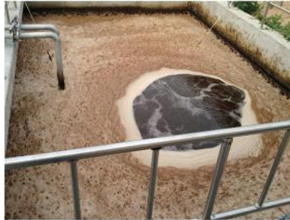
Fig. 7. 마이크로버블을 이용하여 포기조에 산소를 공급하는 모습.
