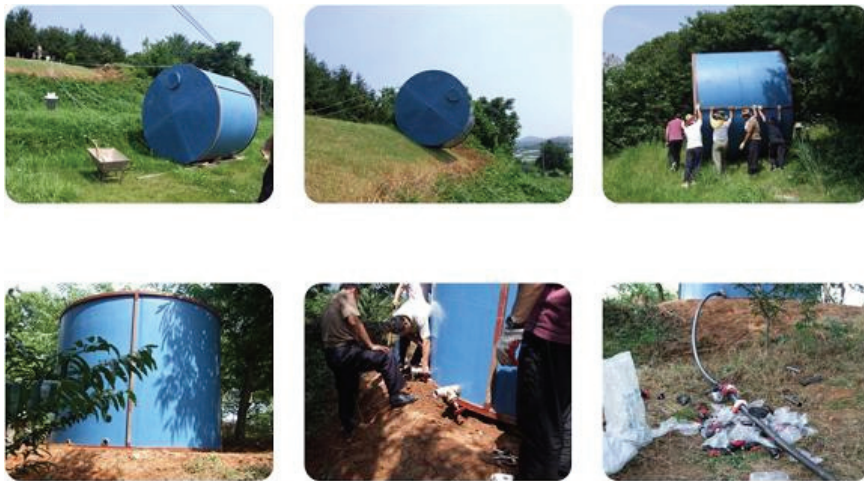
그림 4. 액비저장 탱크 운반 및 설치.
